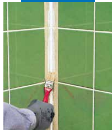
Umezirea etanșantului cu o soluție din apă și săpun în vederea finisării
