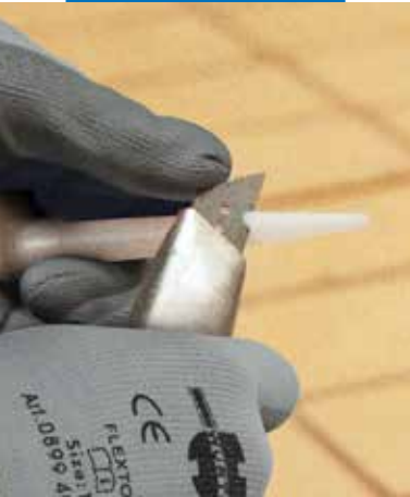
Tăierea capului dozator în funcție de dimensiunea rostului
