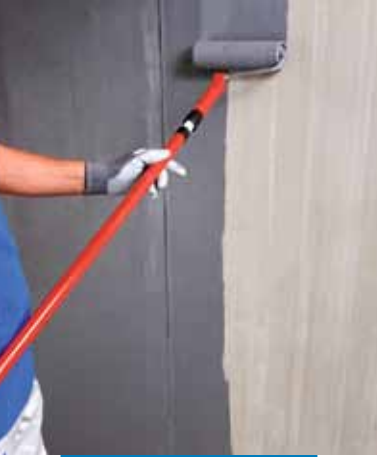
Aplicarea de Eco Prim Grip pe beton, cu trafalet
