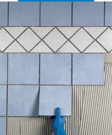
Aplicarea de plăci portelanate pe un perete din gips-carton
